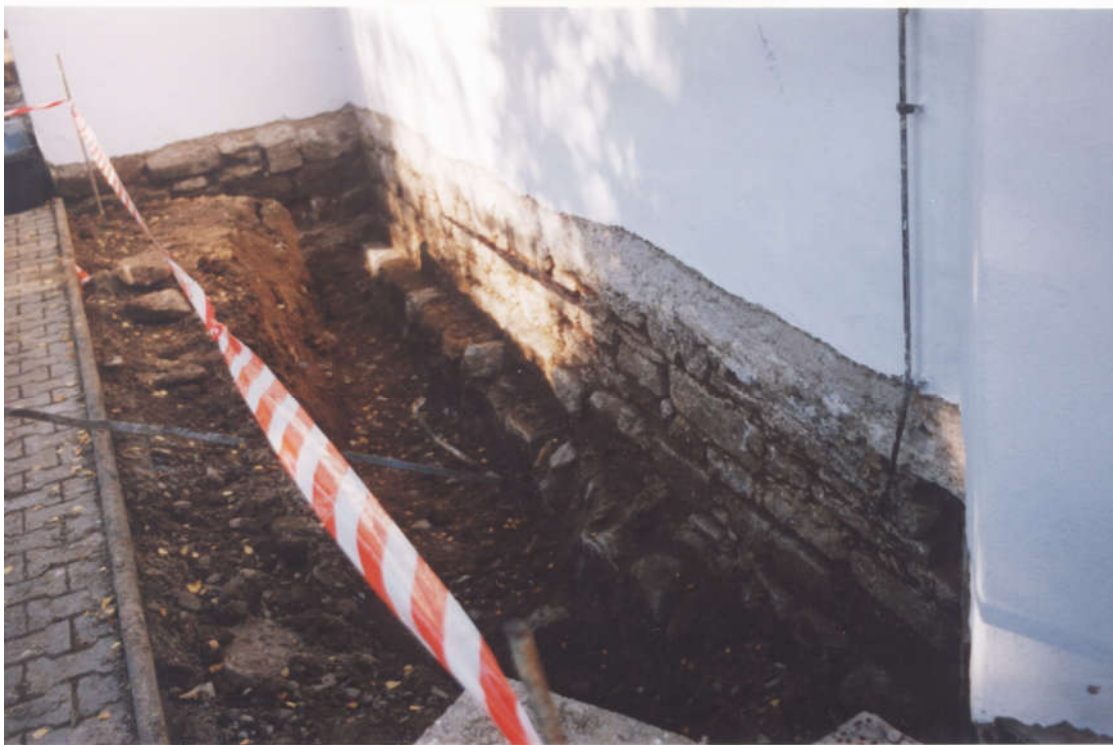
Südwand am Chor
