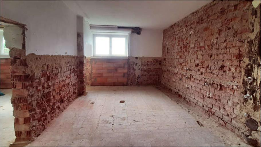
Auch in der Toilettenanlage wurden die Trennwände und die alten Sanitärobjekte demontiert und die Fliesen an Boden und Wänden sind ebenfalls bereits entfernt worden.
